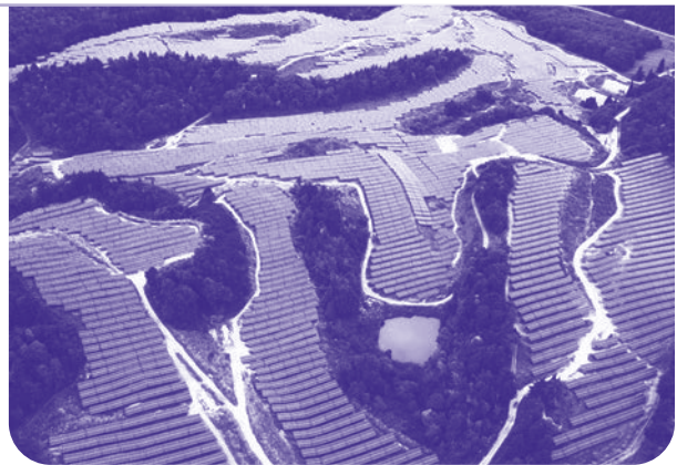
โรงไฟฟ้าพลังงานแสงอาทิตย์ยามางาตะ (Yamagata) จังหวัดยามางาตะ: ประเทศญี่ปุ่น
