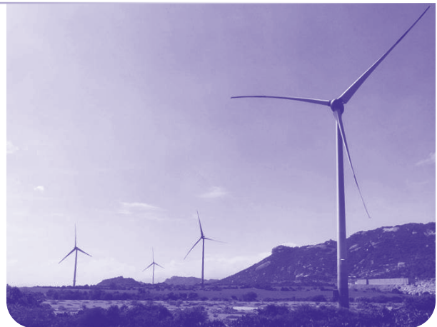
โรงไฟฟ้าพลังงานลมเอลวินหมุยยิน (El Wind Mui Dinh) จังหวัดนันทบุรี สาธารณรัฐสังคมนิยมเวียดนาม
